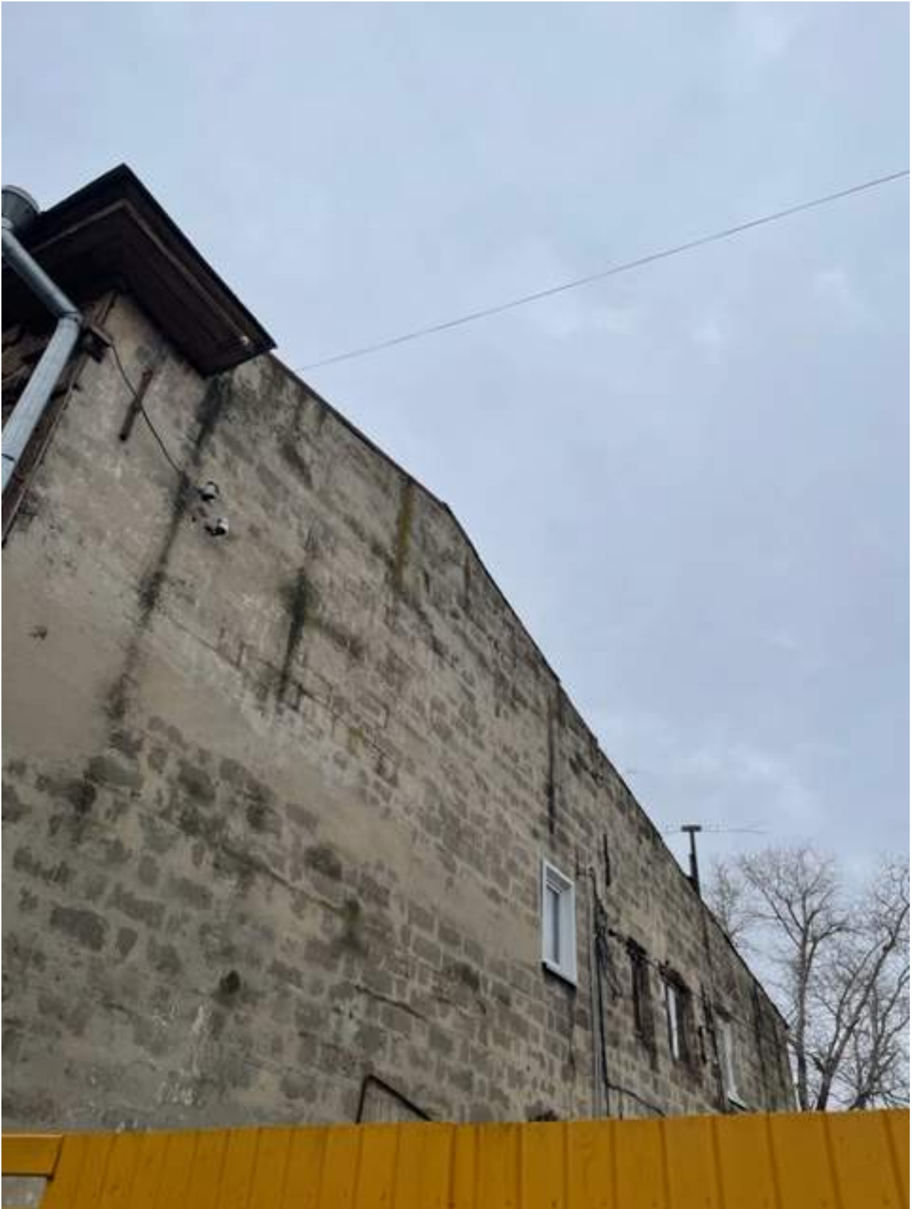
Фото № 17. Материал стен восточного фасада - пустотелые бетонные блоки.
