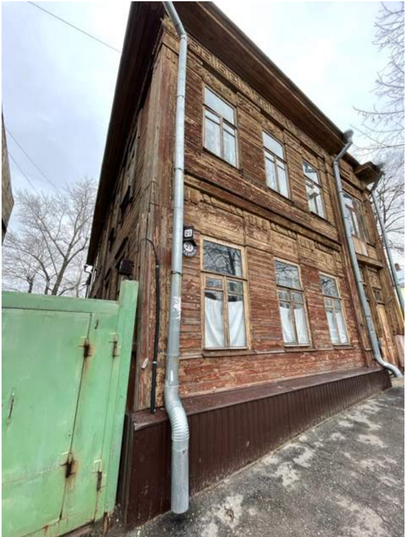
Фото № 5. Угловые пилястры, каннелированные в нижней части.
