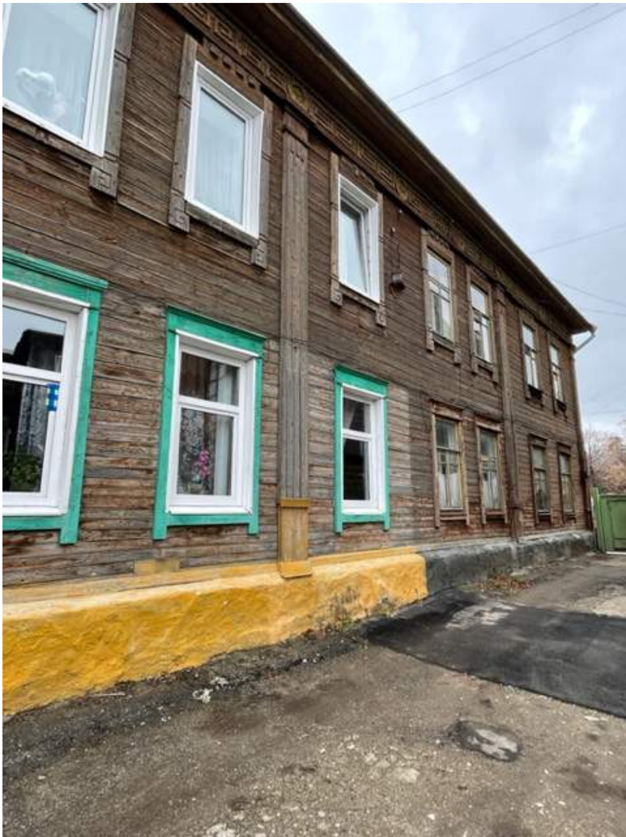
Фото № 3. Цоколь по всему периметру здания, исключая восточный фасад.
